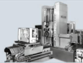
**1962:** HELLER baut numerisch gesteuerte Fräsmaschinen und Bearbeitungszentren mit automatischem Werkzeugwechsel, NC-Plan- und Ausdrehköpfen. Komplexe Arbeitsgänge können auf eine Maschine konzentriert werden.
